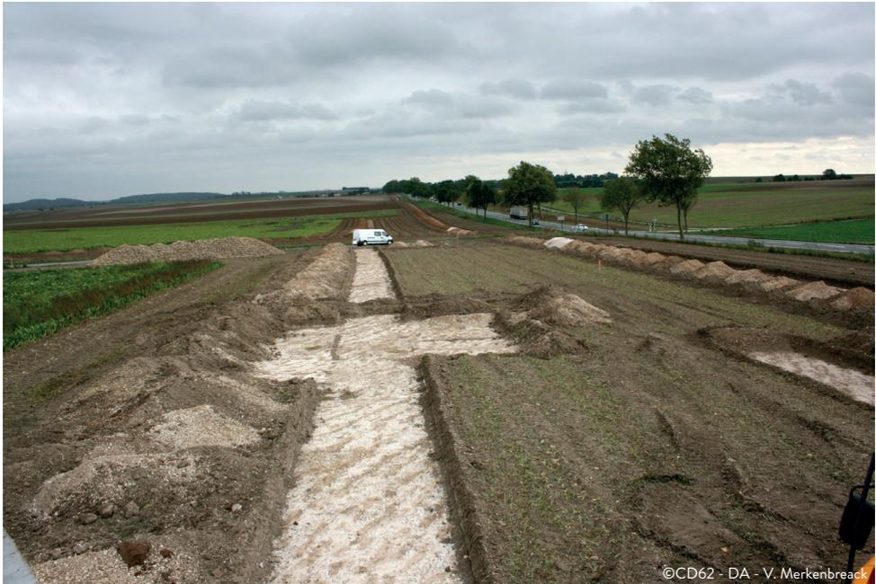
Le principe de la tranchée de sondage permet de porter un regard sur l'ensemble du terrain à évaluer, tout en limitant le nombre d'ouvertures à 10 ou 15% de la surface globale.
