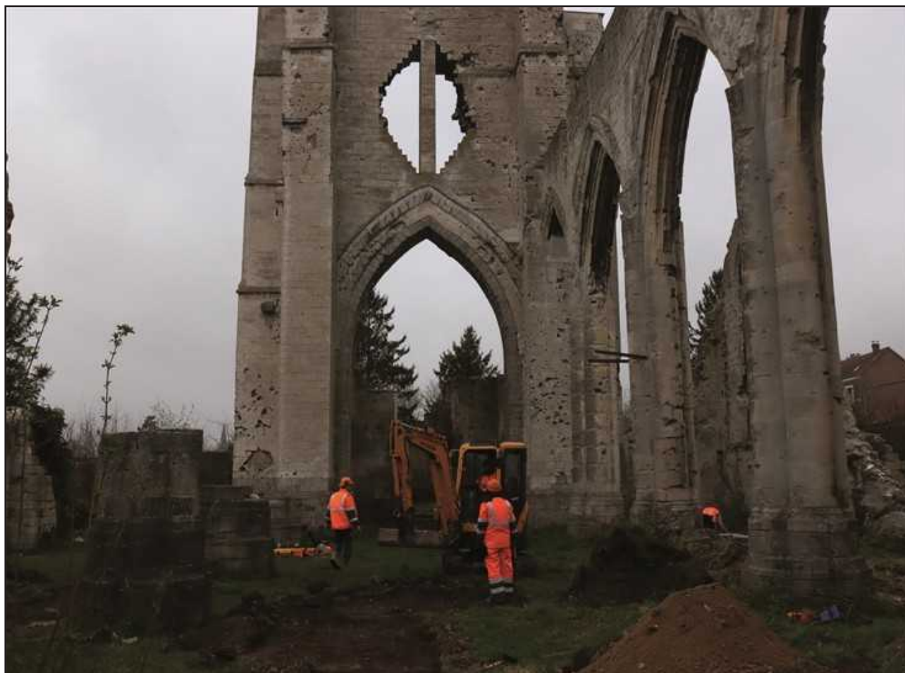
Fig. 16 : Ablain Saint-Nazaire, ruines de l'ancienne église, réalisation d'une tranchée, vue vers l'ouest, L. Wilket - DA, CD 62.
