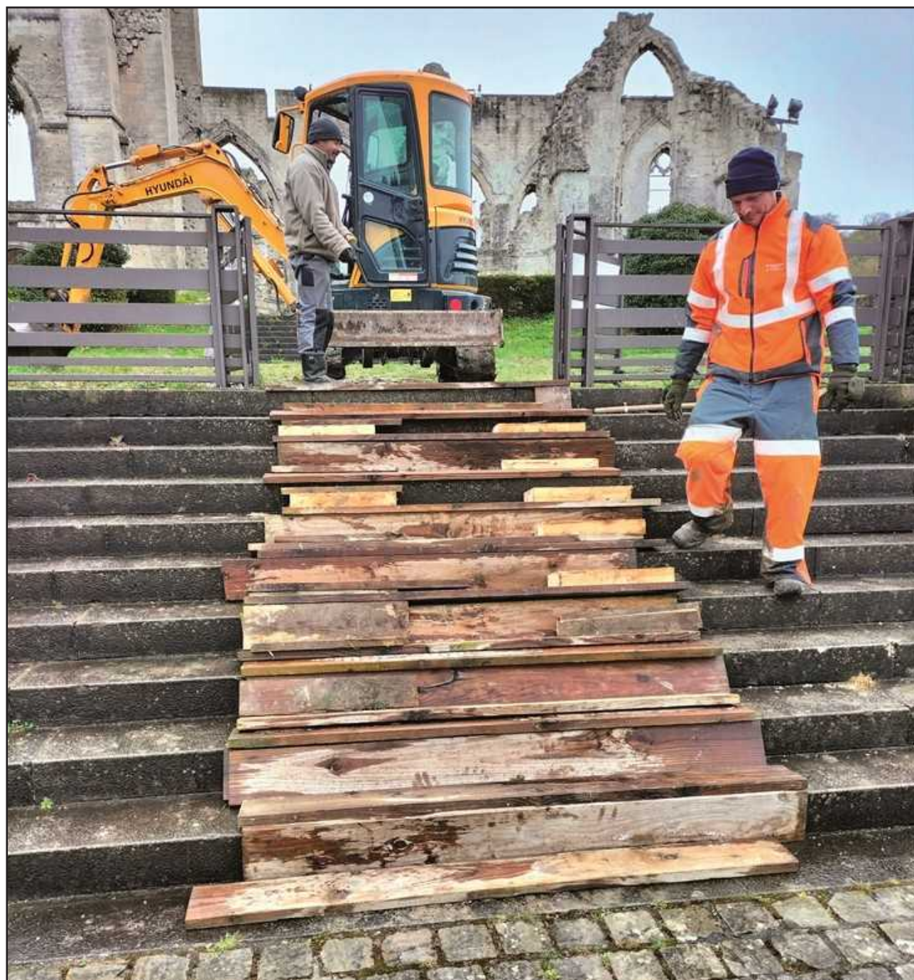
Fig. 14 : Ablain Saint-Nazaire, ruines de l'ancienne église, contraintes : aménagement d'une rampe pour le passage de la pelle, L. Dalmau - DA, CD 62.
