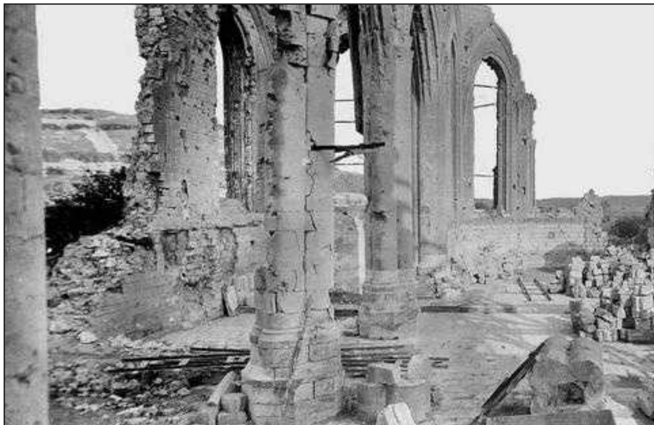
Fig. 58 : Ablain Saint-Nazaire, ruines de l'ancienne église, vue de la phase de reconstruction de l'église, dallage présent dans l'ensemble,
