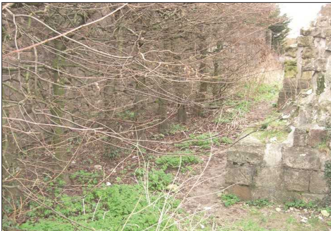
Fig. 13 : Ablain Saint-Nazaire, ruines de l'ancienne église, contraintes environnementales : haie qui entoure l'édifice au niveau du gouttereau nord, L. Dalmau - DA, CD 62.
