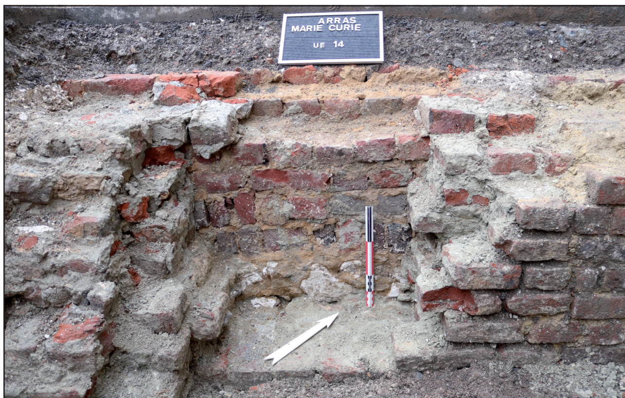
Fig. 30 : Arras, Collège Marie Curie, vue en coupe du mur 14, de sa semelle de fondation et des murs de parement 13 et 15 de la cave 29, cliché H. Agostini, - DA, CD 62.
